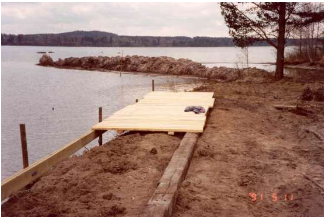
Påbörjad kaj och muddermassor på södra sidan
